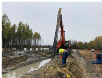
*Photo : tranchée pour le mur sol-bentonite*
