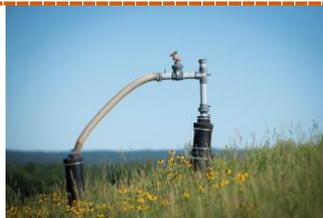
*Photo : puits de captage des biogaz*
